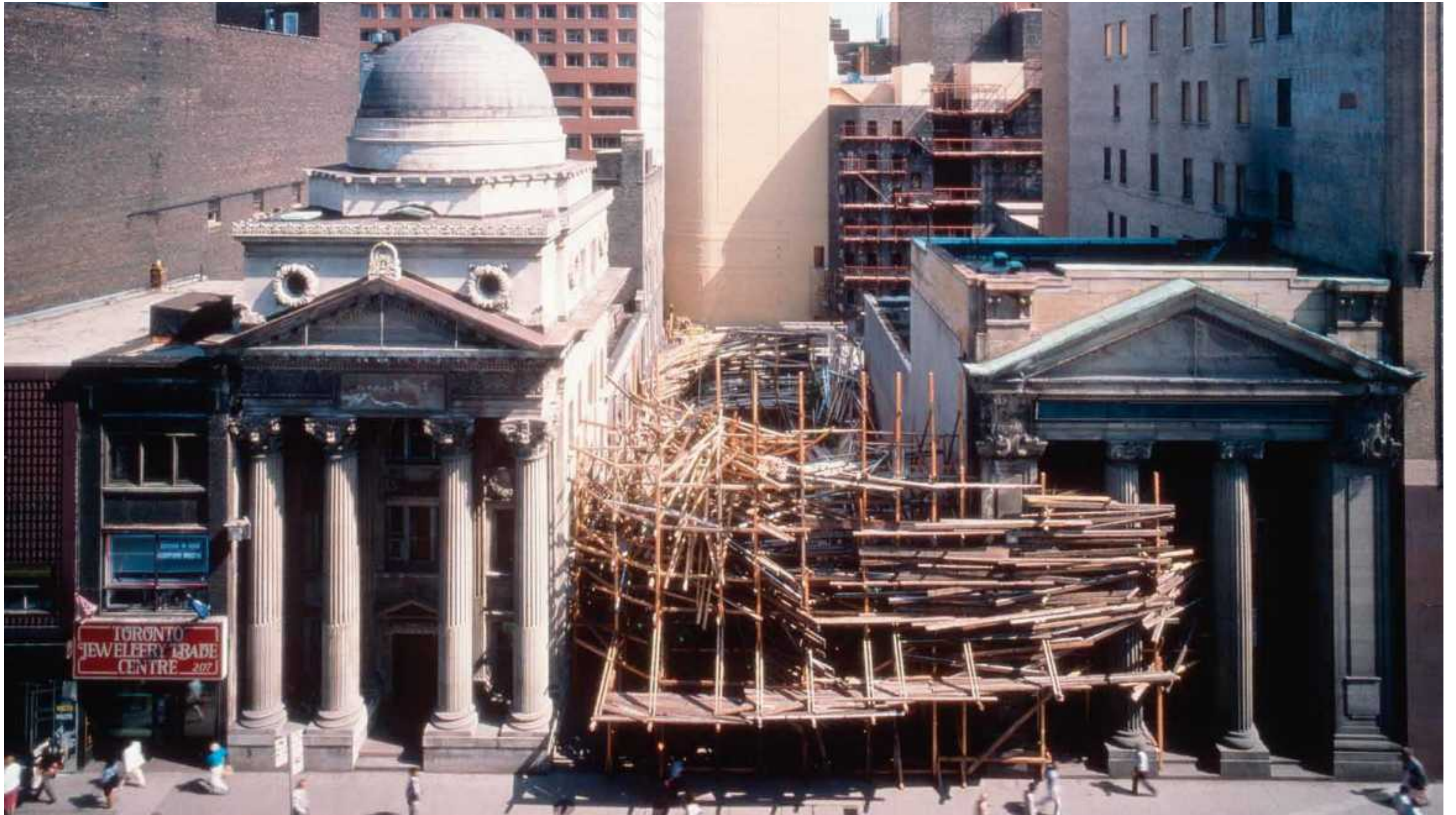
Project at Colonial Tavern Park, juillet - octobre 1989
